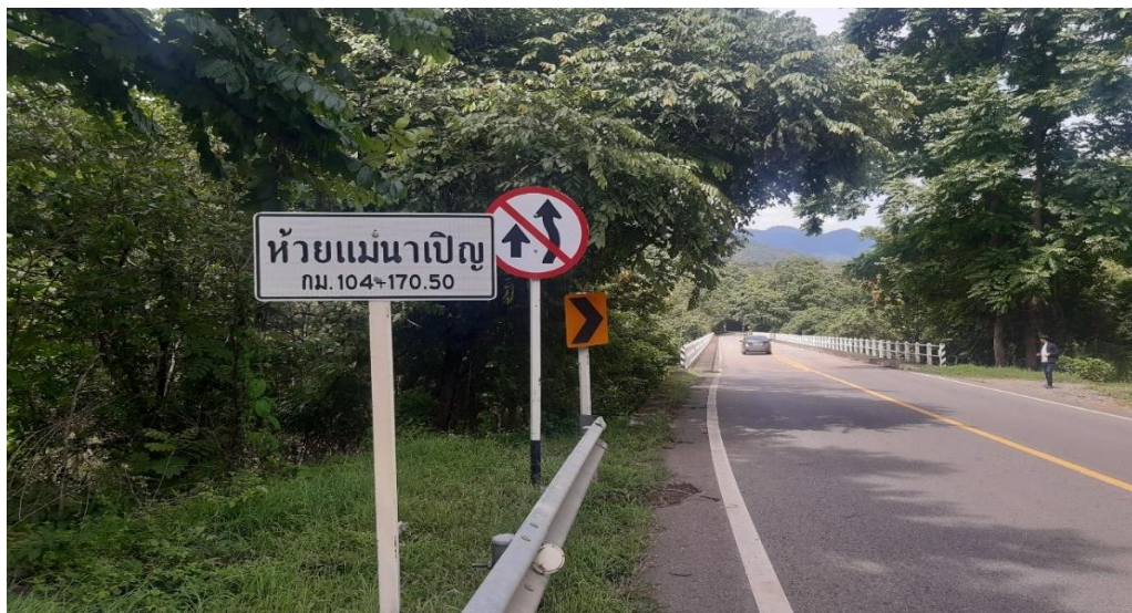
รูปที่ 5-4 สะพานข้ามห้วยแม่ณาเปญ
