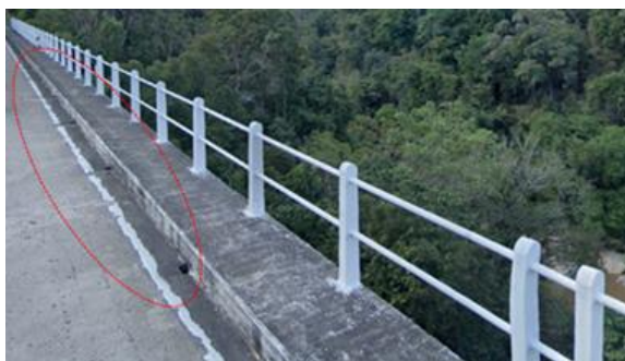
รูปที่ 5-11 สภาพปัจจุบันของระบบระบายน้ำบนสะพาน
