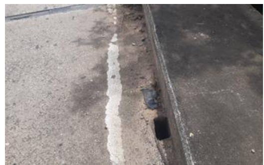
รูปที่ 5-11 สภาพปัจจุบันของระบบระบายน้ำบนสะพาน
